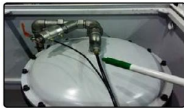
6.5 지그 상단에 인양용 2관절 바를 설치
